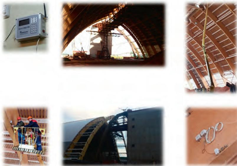
**Рис. 3. Система мониторинга деформации кровли в ОАО «Уралкалий» г. Березники, Пермский край**
