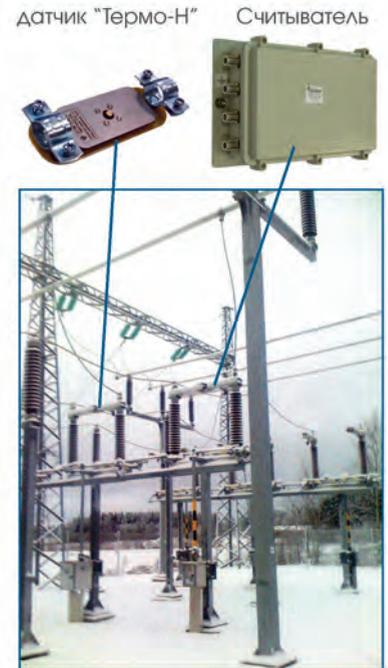
Рисунок 5. Структурная схема системы ПАВ-ТЕРМО-Н
