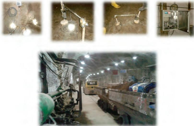
**Рис. 2. Система деформационного мониторинга на руднике «Глубокий» ОАО «ППГХО» г. Краснокаменск**
