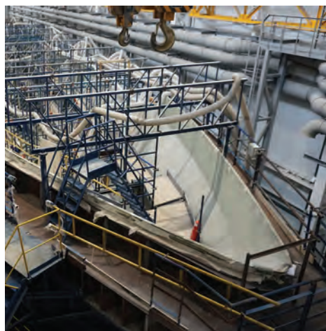
Серийное строительство кораблей противоминной обороны
