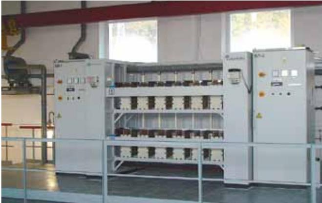
S.A.A. "Avangard" fabrica, suministra y realiza las obras de puesta en marcha y de instalación de los conjuntos de equipos de electrólisis basados en la tecnología innovadora y ecológica de ahorro de energía para la producción de hipoclorito de sodio de baja concentración el que es el reagente de desinfectar el agua potable y los residuos y el agua reciclada de la industria. La materia prima para la producción de hipoclorito de sodio es un producto ecológico, sal de cocina.
